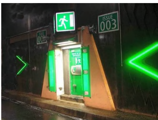
Figure 11: Eclairage des issues en mode évacuation
